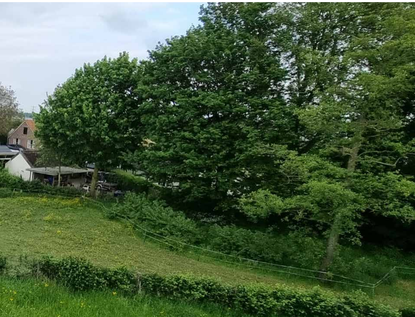
Tracérestant van de Spanjaardsdijk tussen de Kolk van Valkenier en de dijk bij De Engel
