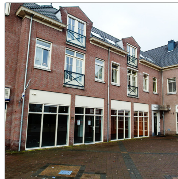
Niet-dagelijks aanbod kwetsbaar
