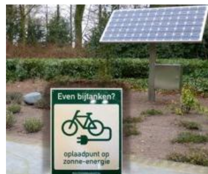
elektrisch oplaadpunt op zonne-energie
