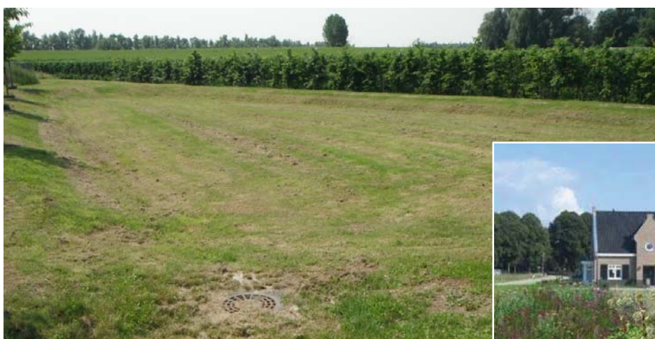
Bestaande wadi ten behoeve van waterberging, retentie en infiltratie én een voorbeeld van functies combineren met biodiversiteit
