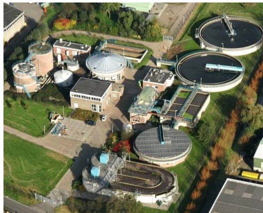
Moderne waterzuiveringsinstallatie (RWZI)
