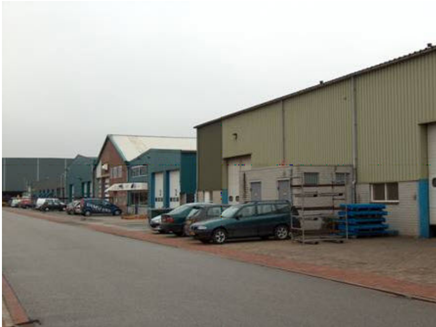
Nijverheidsweg, 't Panhuis Kenmerken van de bebouwing
